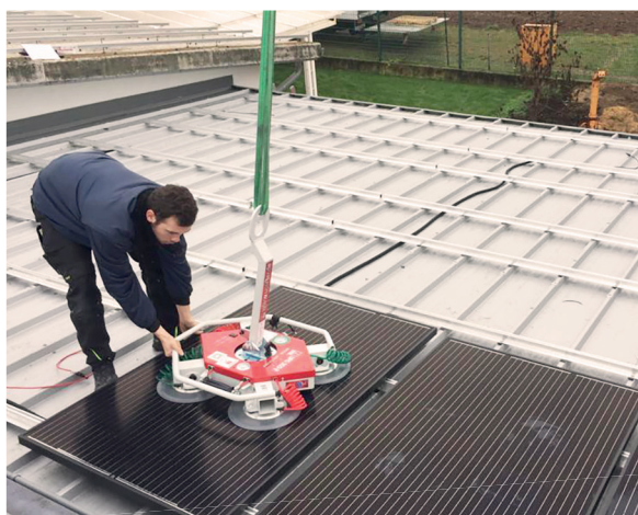
UPG350 zvládne manipulaci prvků jako např. solární panely, dřevo, kovové nebo plastové desky a mnoha dalších
